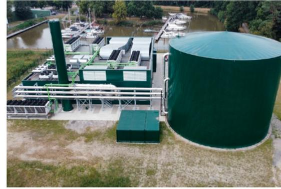
In Papenburg wurde 2024 der erste Green Cube installiert: Ein KWK-Kraftwerk mit Wärmepumpen und Wärmespeicher.
